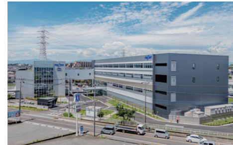
埼玉事業所 狭山インテグレーションセンター (写真 建屋右) 所在地 埼玉県狭山市北入曽 613 延床面積 約 8,200㎡
