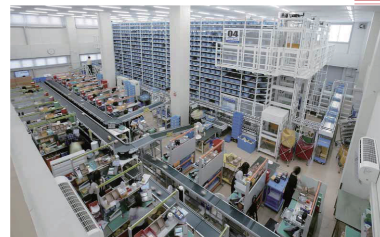
4号棟に設置されたバラ品ピッキング用の多段式独立水平回転棚「ロータリーラックH」と検品・梱包ライン
