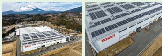
御殿場事業所の太陽光パネル
