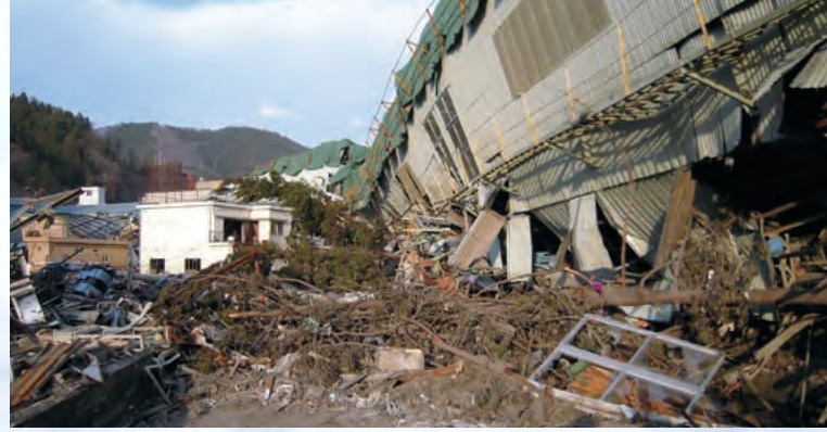
津波により建屋が倒壊した旧工場
