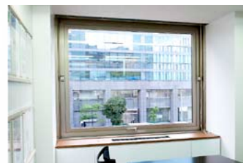
窓面の断熱フィルムによる空調負荷低減
