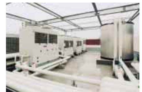
除湿効果でショーケースの霜取りを抑制するデシカント空調システム
