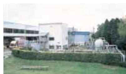
富士サイトの排水処理設備
